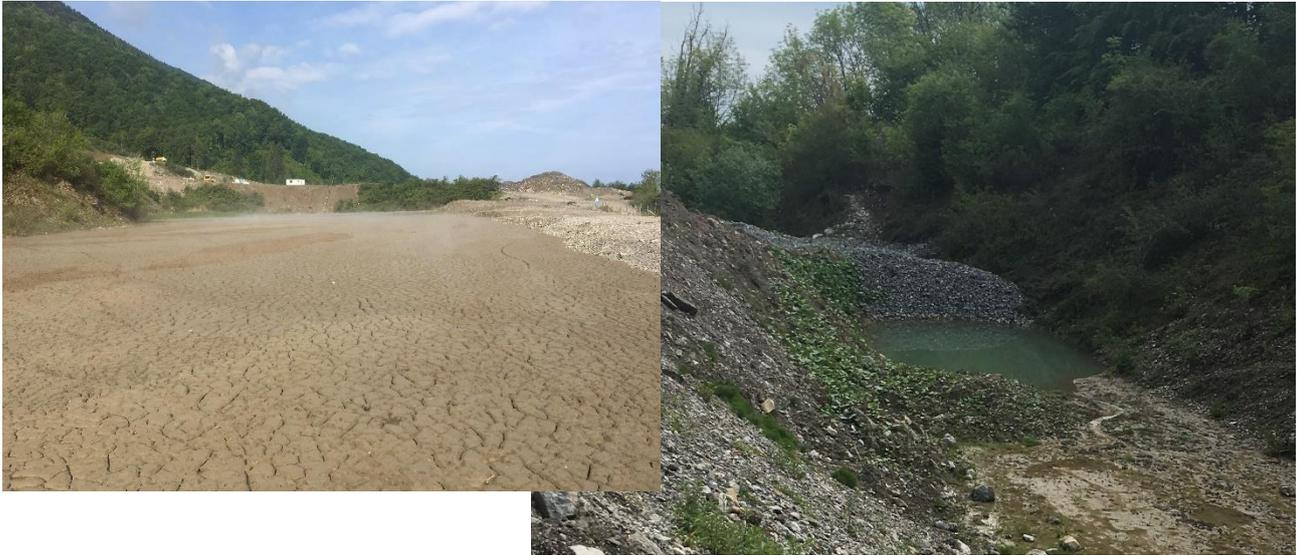
L'éluva abouti dans une gouille dont le trop plein est accompagné via un fossé vers la traversée de la piste cyclage en PE annelé DN 800mm environ, puis rejoint la voie SNCF via un fossé bétonné de section rectangulaire puis un pertuis maçonné. Le dimensionnement sous la piste cyclable n'apparaît pas en adéquation avec le potentiel de transfert aval.
