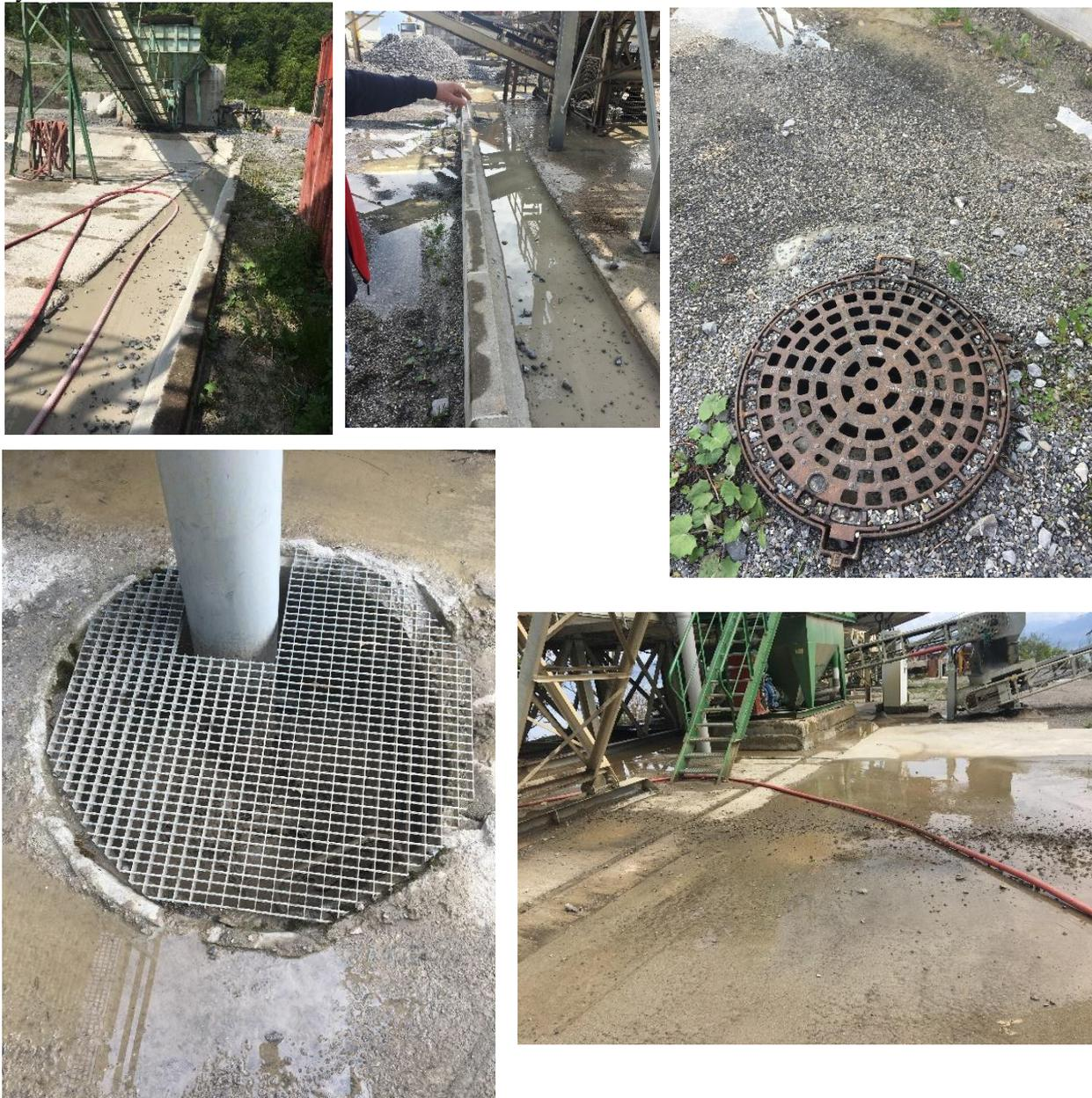
Le lavage des camions est réalisé en circuit fermé à partir de la bêche à proximité immédiate de la piste de lavage. Une cellule de photo détection permet l'enclenchement d'un cycle de pompage des arroseurs. Le ressuyage est orienté en ruissellement vers la même bêche. Une temporisation permet également l'arrosage de la piste d'accès au site à partir de cette même installation ( activée selon les conditions météo et formation de poussières).
