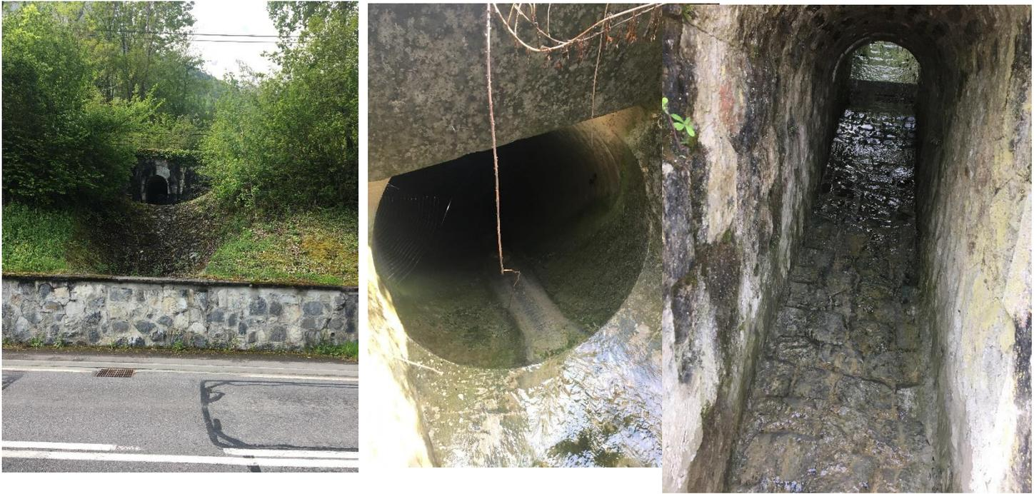
A l'aval du franchissement SNCF, le débit est engagé préférentiellement vers un DN1000 en Béton libéré dans une chute à gueule bée accompagnée au lac à l'aval de la route. La surverse de cet entonnement rejoint un fossé en empierrement liaisonné béton réinjecté vers le DN1000 via deux grilles fontes eaux pluviales coté amont de la route.
