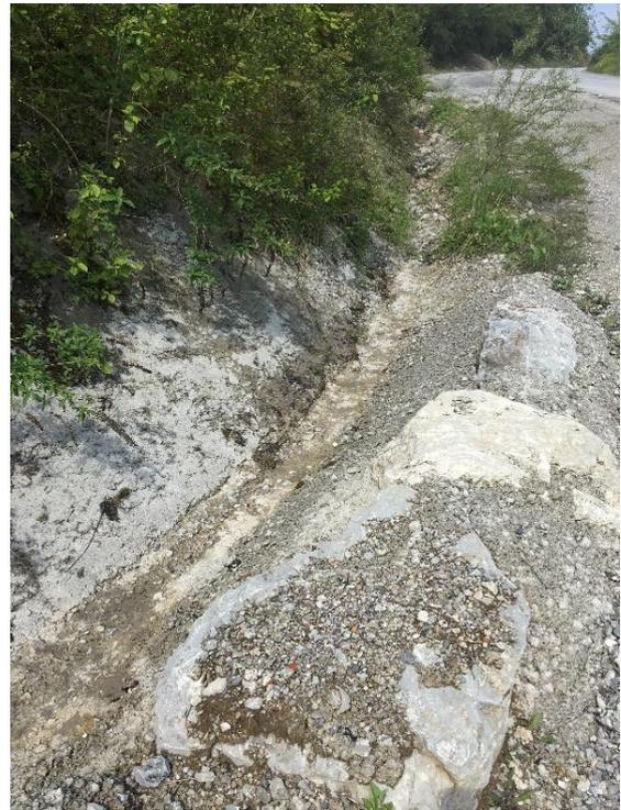
Nota : Au vu du principe de mise en œuvre du départ de l’entonnement, un colmatage est à prévoir.... Néanmoins, le débordement par ruissellement de surface est intercepté par le bassin à l’aval devant la pente traversière existante de la chaussée...
