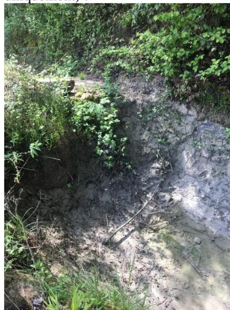
Puis le fossé est non revêtu , hormis quelques mètres avec enrochements liaisonnés béton en amont immédiat de la nouvelle tête de busage (créé à l’occasion du nouveau cheminement mis en œuvre en amont du bassin de l’entrée du site).
